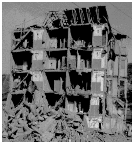
Рис. 3.2. Обрушение части крупнопанельного здания при землетрясении
