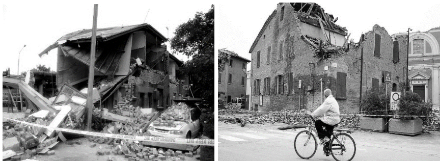
Рис. 3.3. Повреждения каменных зданий при сейсмическом воздействии
